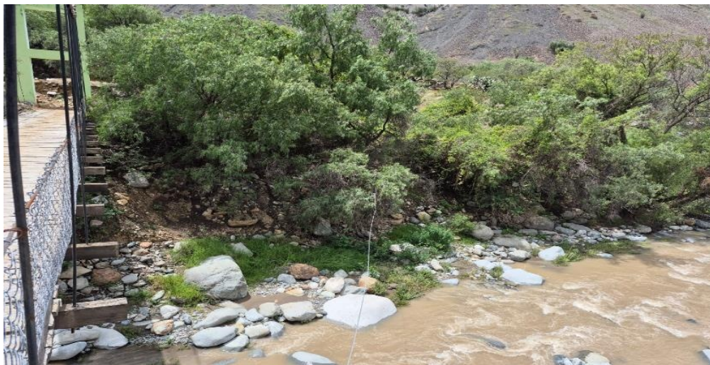
FOTOGRAFIA N°02: TRAMO CRÍTICO EN EL RÍO SANTUARIO, EN LA LOCALIDAD DE JUAN DE LOZA, ENCONTRÁNDOSE EL TALUD DEL PUENTE PEATONAL SOCAVADO.
